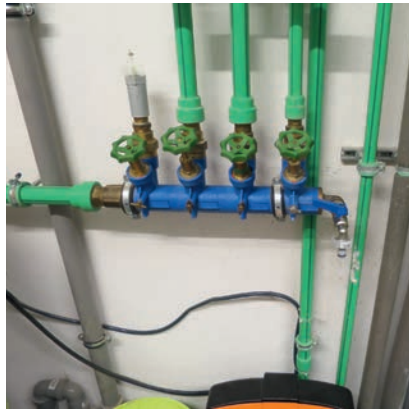
Bild 5: Exemplarische Entnahmestellen vor und nach der Enthärtungsanlage.
