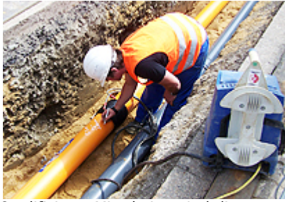
Qualifizierte Mitarbeiter sind die Grundlage für fachgerechtes Arbeiten im Leitungsbau. Foto: rbv
